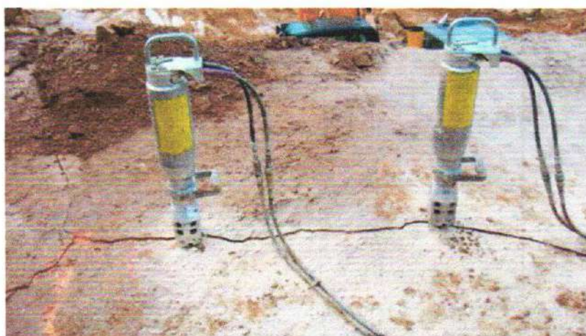
Figura 1 - Rompedor pneumático com cunha hidráulica
